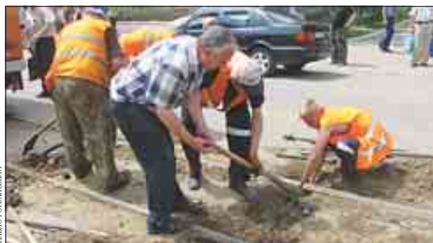
Ремонтникам довелось ладнати пошкоджену колію
